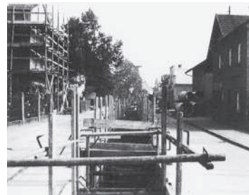
Bereits vor Beginn der Straßenbaumaßnahmen wurden die Kläranlage erweitert und das Kanalnetz großzügig ausgebaut, die großen Rohre der Hauptsammler waren bereits unterirdisch verlegt.
