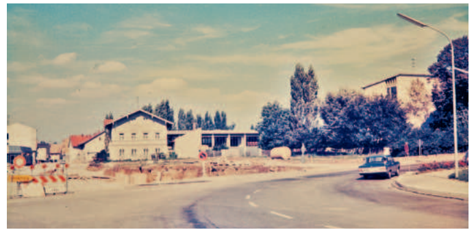
Bauarbeiten an der Münchner Straße/Ecke Bahnhofstraße.
