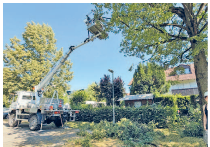
Baumpflegearbeiten gegenüber des Kindergartens an der St.-Florian-Straße 13. Foto: Gemeinde Ufg/lih
