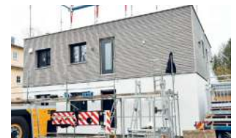
Im August sollen die Fertighäuser mit insgesamt acht Wohnungen bezugsfertig sein.
