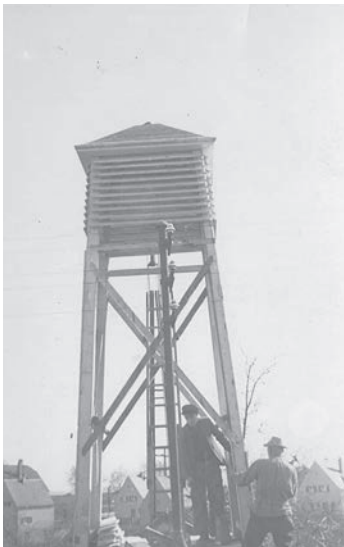
Die Feuerwehrmitglieder Stefan Straßer und Alois Dudek beim Bau des Schlauchturmes.
