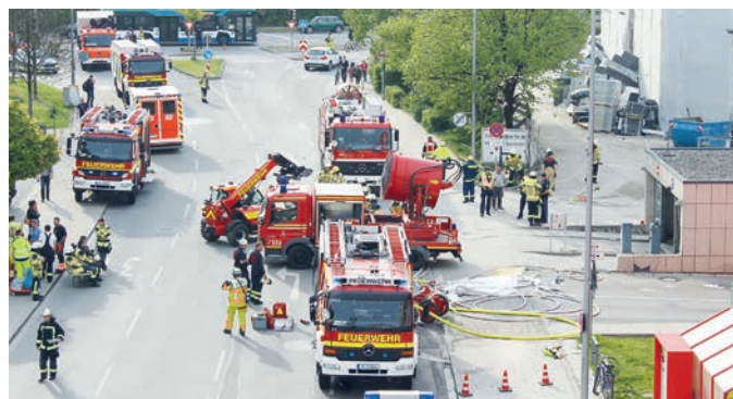
In einer Tiefgarage der Großbaustelle brannte es. Foto: FFW Ufg
