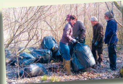
Bergung von Mineralwolle, die in mehreren Säcken verpackt ist.
