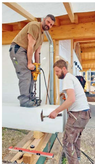
Das Loch für den Bolzen bohrten Andreas Schwinghammer (l.) und Korbinian Vaitl. Foto: G. Behrendt
