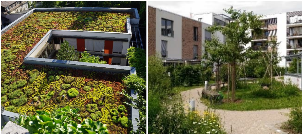
Abbildung 8: Oberflächennahe Rückhaltung auf Gründächer (Adobe Stock) und Tiefgaragen (HL)
