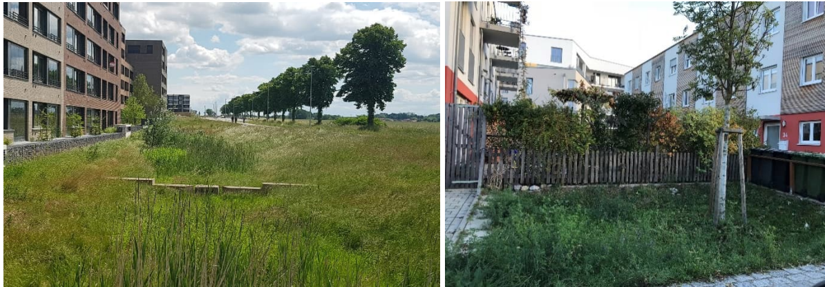
Abbildung 10: Integration einer Mulde in eine Grünfläche (links) oder in einem abgegrenzten Bereich (rechts) (HL)
