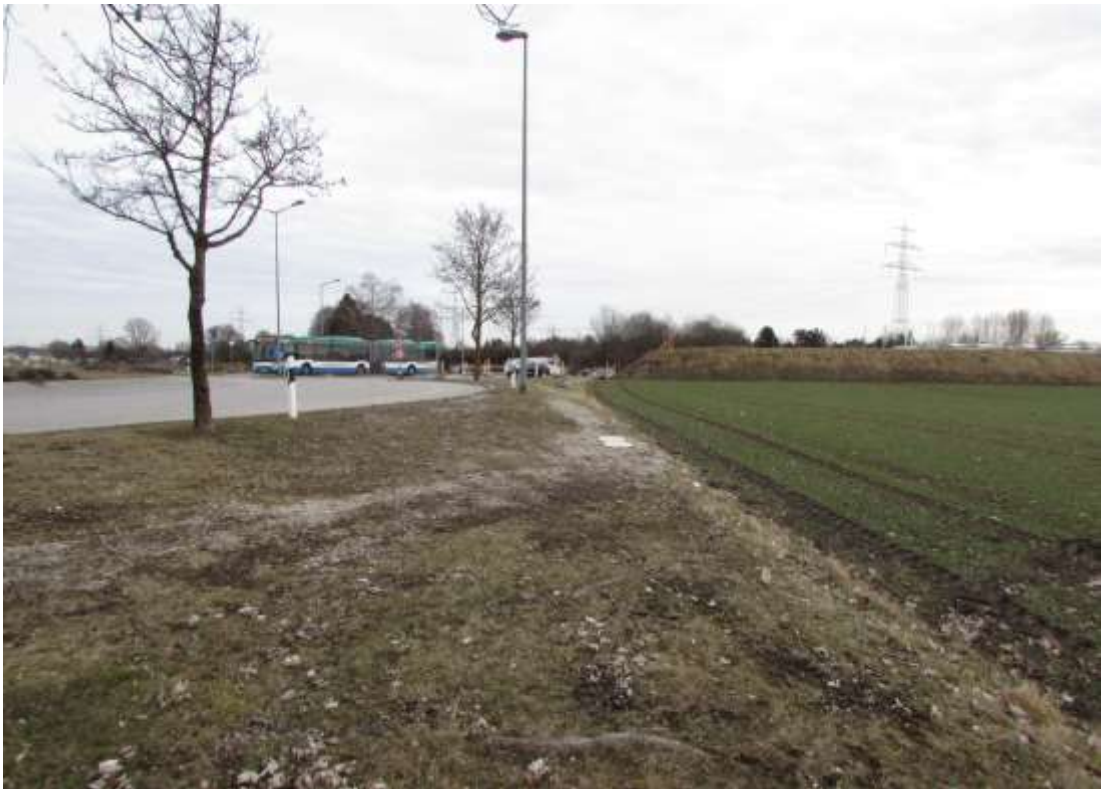
Abb. 3: Südliche Böschung des südlichen Kreisverkehrs
