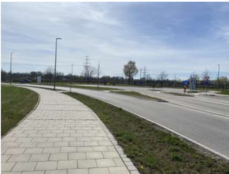
Abb. 8: Blick auf die neue Straßenführung (2022)
