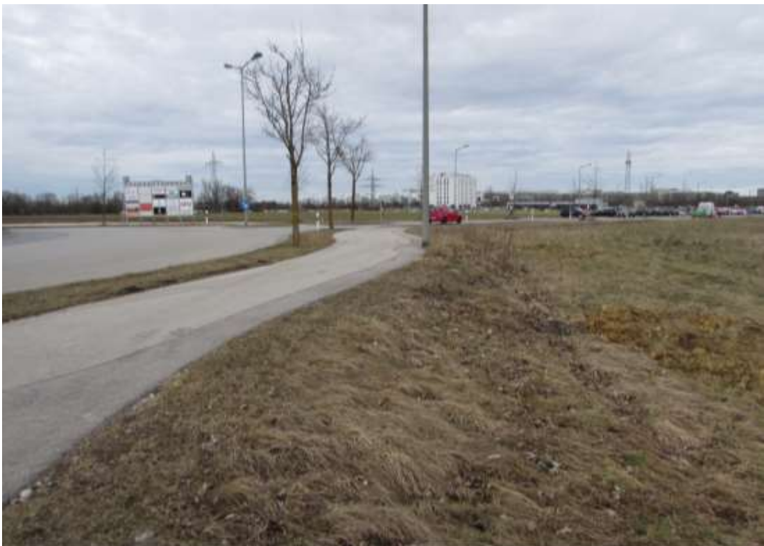
Abb. 2: Nordöstliche Böschung des südlichen Kreisverkehrs, hier soll der Bypass entlangführen
